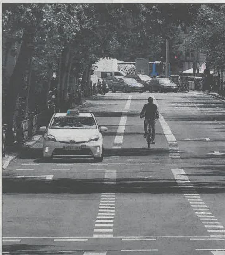
Nuevo carril bici instalado en la calle de Sagasta. / KIKE PARA
