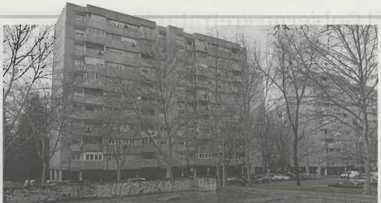
Los bloques 76 y 78 de la calle Rafaela Ybarra, en Orcasitas
